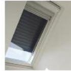
Reduktion der Wärmeeinstrahlung durch das Fenster bei Verwendung eines Aussenrollladens.
